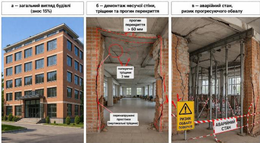
Рис. 1. Аварійний технічний стан при мінімальному фізичному зносі (15%)
