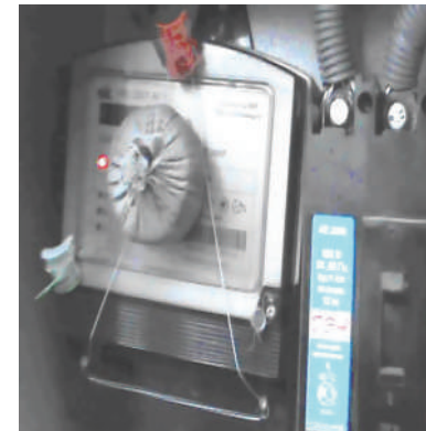
Рис. 2. Електронно-механічний лічильник із встановленим на ньому магнітом для безоблікового споживання електроенергії
