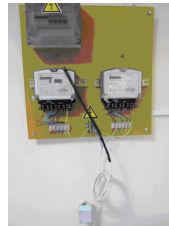
Рис. 3. Спосіб застосування пристрою електромагнітного випромінювання високої частоти для безоблікового споживання електроенергії електронно-механічним електролічильником
