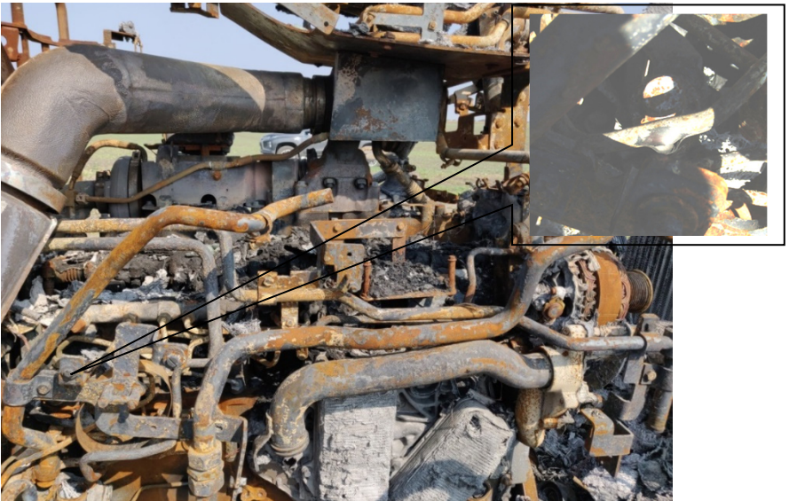
Рис. 2. Зображення місця розгерметизації паливопроводу системи впорскування дизельного двигуна внутрішнього згорання трактора FENDT 936 VARIO S4.
